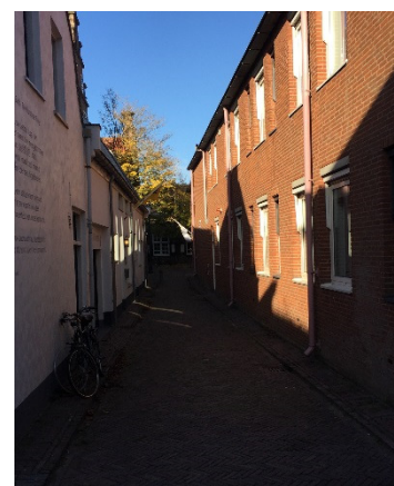
Fig 3.8 Duivensteeg vanaf Gansoordstraat
