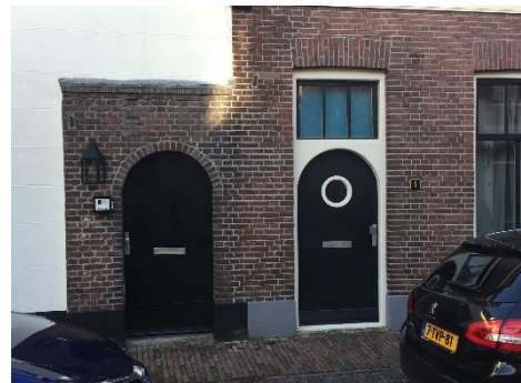
Fig 3.6 Deuren waar hoger dicht hek geplaatst zal worden
